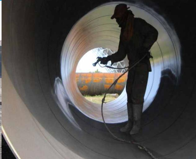
**Protective Coating melindungi semua konstruksi dari cuaca dan korosi (karat) Selain melindungi, Protective Coating ini juga mencegah kerusakan sehingga permukaan konstruksi dapat tahan lebih lama. TAM Coating terbukti mampu memberi perlindungan prima pada berbagai industri migas dan konstruksi seperti jembatan, pipa, tanki hingga dermaga.**
