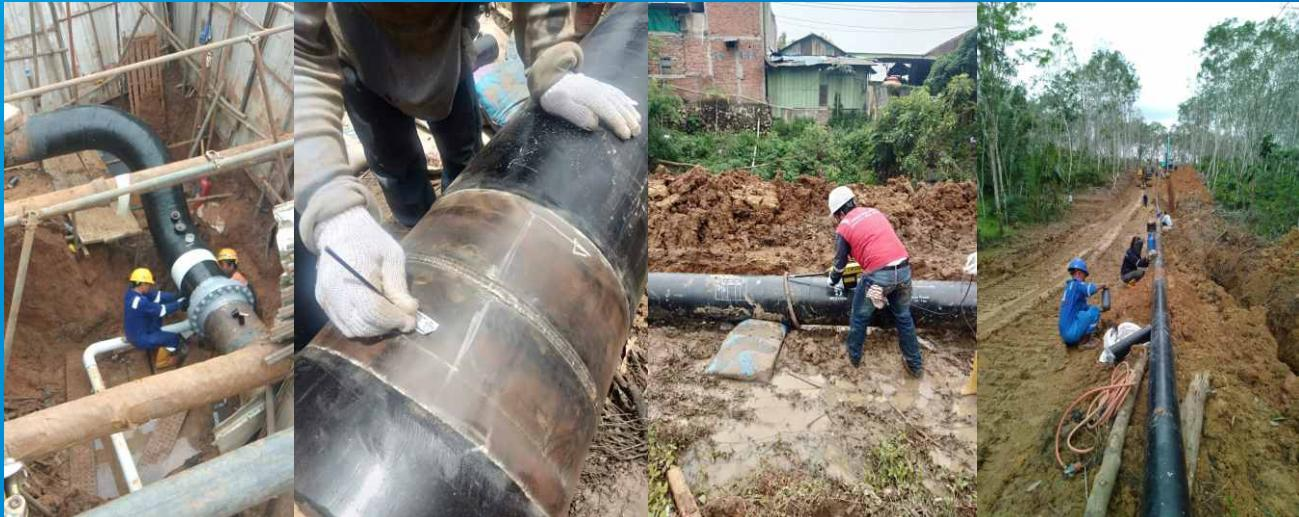
Field Joint adalah Sambungan pipa di mana dua bagian pipa dilas bersama. Saat pembangunan pipa, setiap batang pipa 12m diletakkan ujung ke ujung, dan kedua ujung pipa ini ditempatkan di lokasi dan kemudian dilas, dimana area yang dilas ini disebut dengan field joint. Long line pipeline memiliki banyak sekali field joint yang harus di proteksi / coated.
