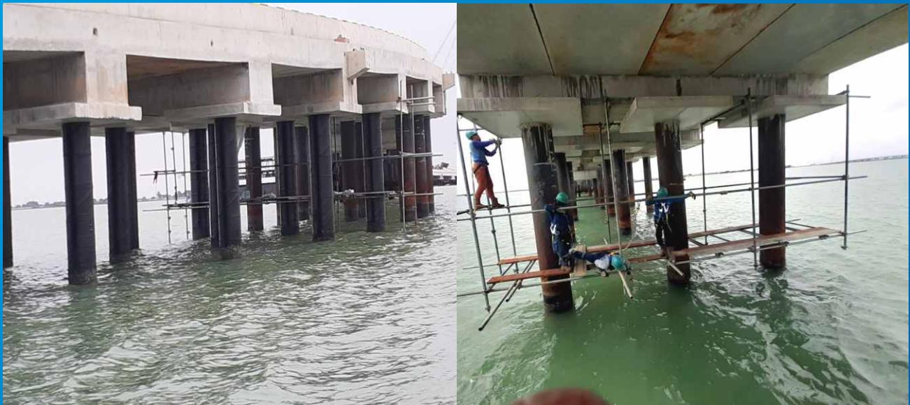
Composite Wrapping Umumnya di gunakan di daerah splash zone untuk Jetty Pile dimana Splash Zone Area adalah struktur marine yang terekspose oleh:
