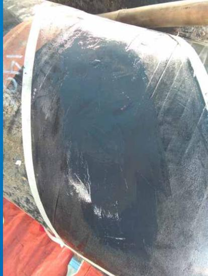
**Metal Adhesive** adalah jenis patching dengan menggunakan bolted steel plate tanpa pengelasan atau hot work, dengan menggunakan metal adhesive sebagai cold welding.
